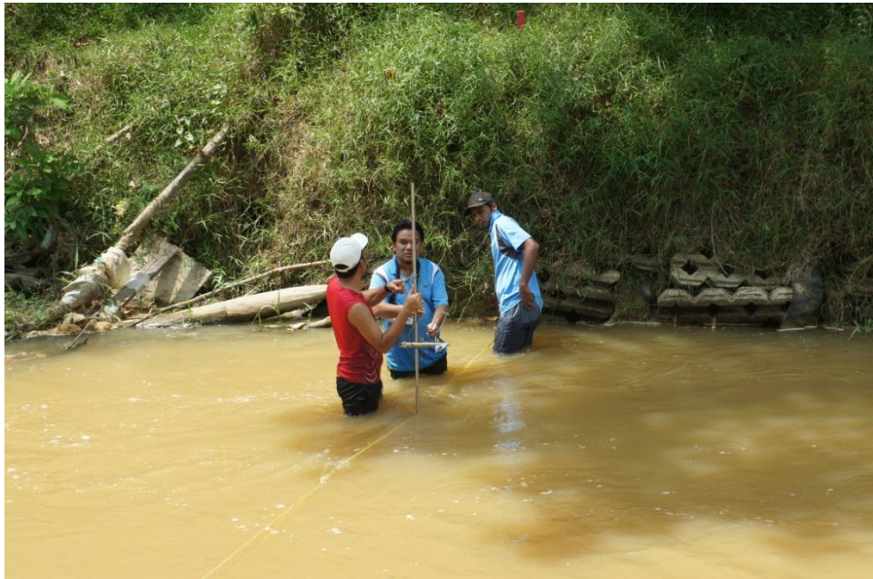
Pelarasan Flow Meter mengikut kesesuaian titik kiraan
